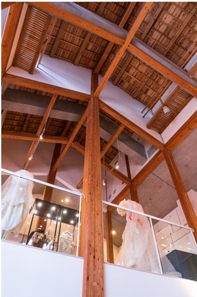
【1階から見上げた棟持柱】
