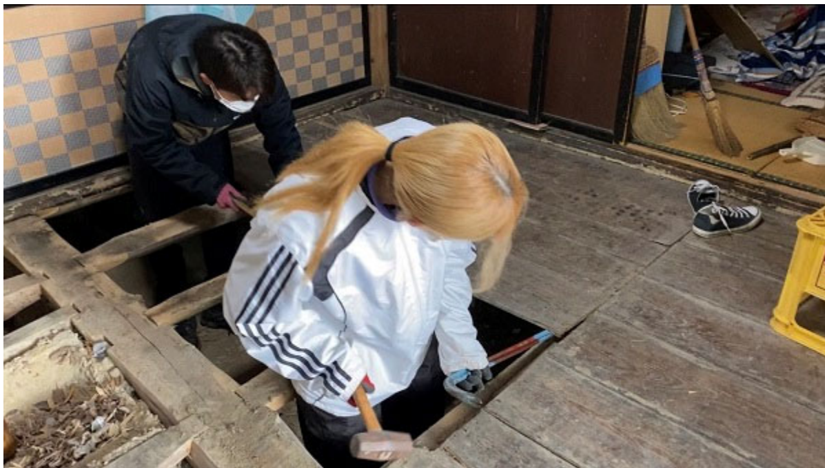
【2021年11月 古民家の床下に断熱材を入れる改装作業の様子】
